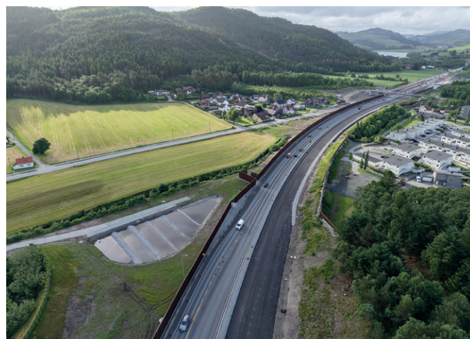
Alt det vesentligste i prosjektet er gjennomført. Nå ferdigstilles de siste elementene; de siste lagene med asfalt legges, og så skal linjemarkeringen på plass. Foto: Statens vegvesen.
