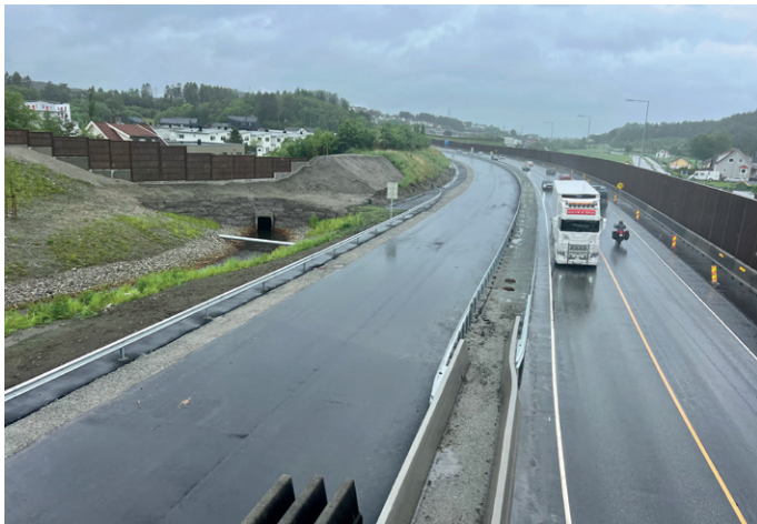
Trafikkstøyreduksjon har vært et vesentlig element. I prosjektet er det investert betydelige beløp til blant annet støyvegger og glasskjermer langs E39.
