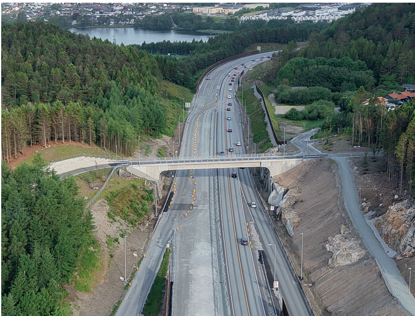
På vegens høyeste punkt er en gammel gangbru over vegen erstattet av denne nye, som er betydelig lengre og sikrere. Foto: Statens vegvesen.
