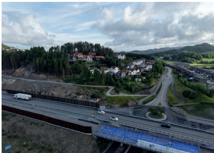
Bildet er tatt under ombyggingen av et toplanskryss ved boligområdet Bogafjell. Foto: Statens vegvesen.
