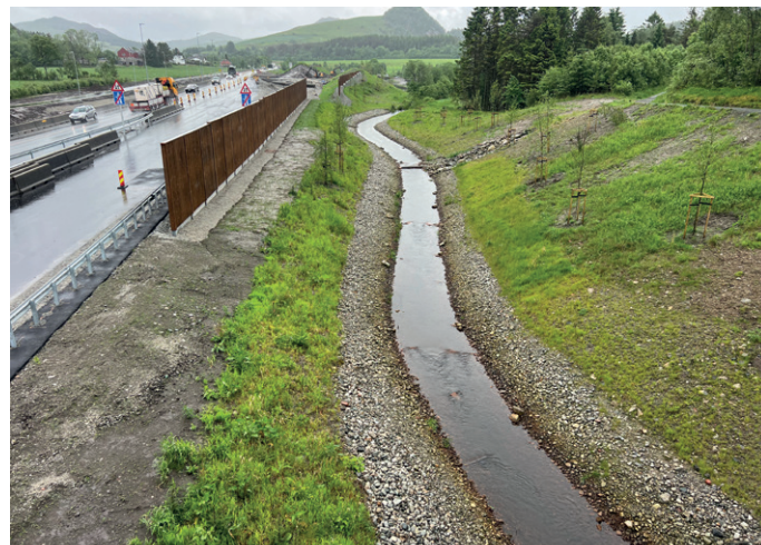
Prosjektet rommer også omleggingen av en kanal til lakseførende vassdrag.
